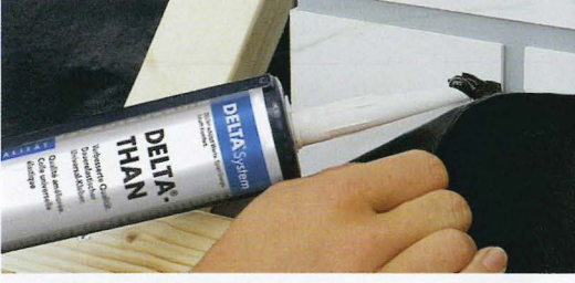
Birleşim detayında DELTA®-THAN ile güvenli yapıştırma. Çatı üzerinde hareket ederken maksimum güvenlik.
